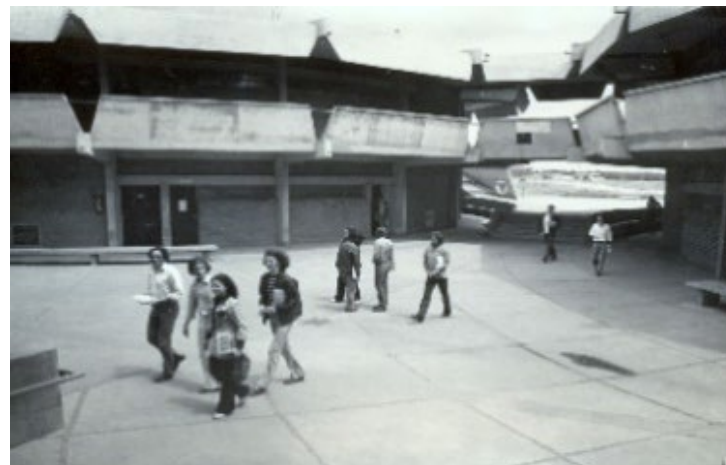
Acesso às Salas de Aula
