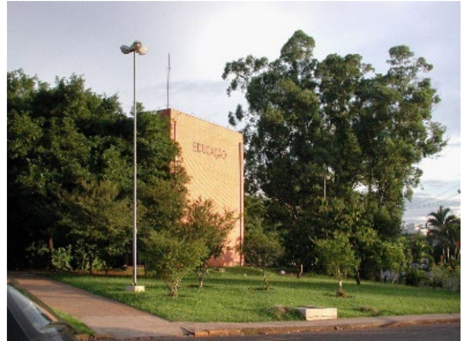
Fachada da Faculdade de Educação
