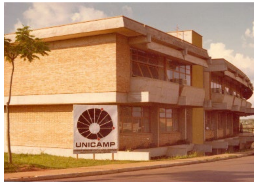
Vista da fachada do prédio do Ciclo Básico, instalada a Faculdade de Educação (FE) na década de 70.
