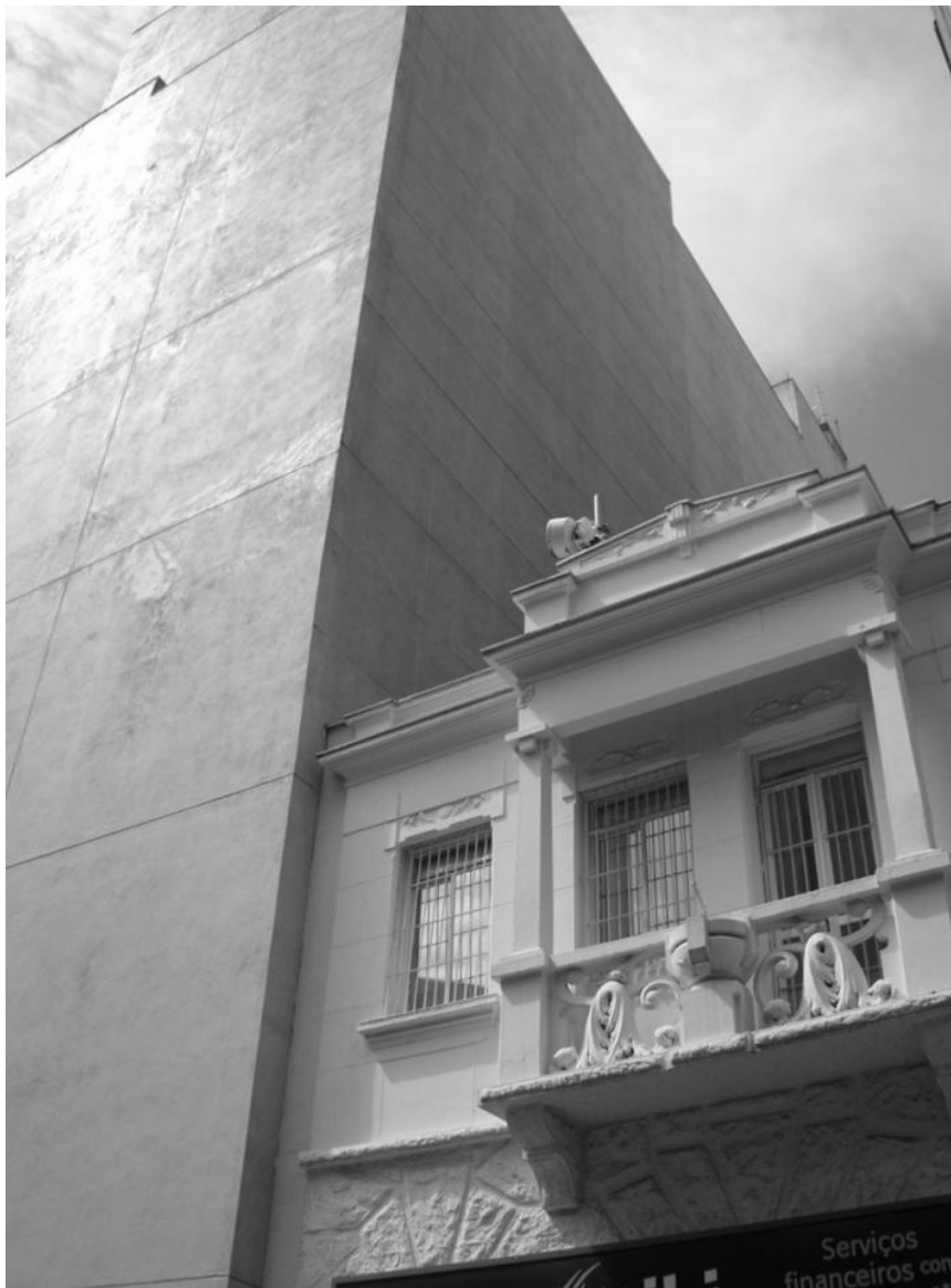
Figura 10 Fotografia que comprova serem os padrões de construção desta área central do município um dos fatores condicionantes dos conflitos de sombra e conforto existentes.
